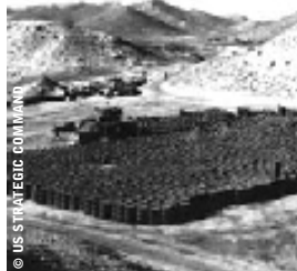
PHOTO OFFICIELLE DES BIDONS DE TERRE ET DE VÉGÉTATION DÉBLAYÉES À PALOMARES. 4
